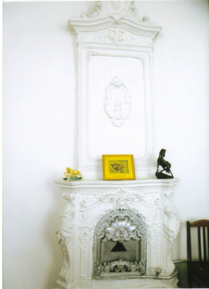
Həmin binada soba
