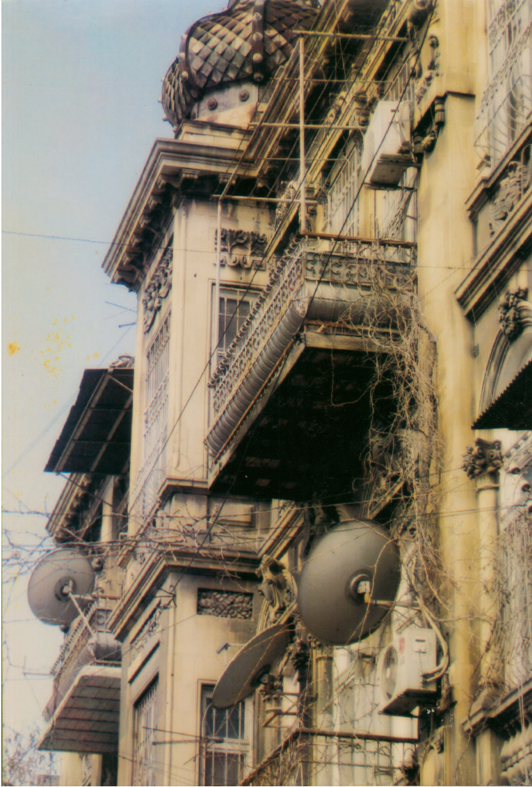
Şəmsi Bədəlbəyli 24 – sökülmüş binası
